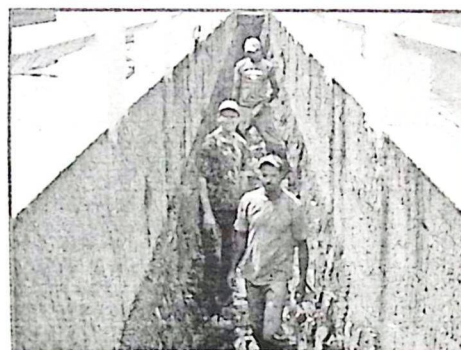
Foto depois da limpeza realizada
