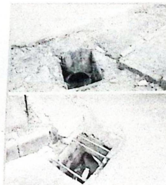
Bueiro sem proteção flagrado na Avenida Jary Sérgio de Oliveira
