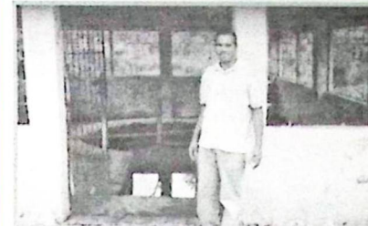
Vereador Fabrício conferindo "in loco" a precariedade da fonte.
