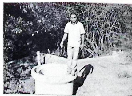
Vereador Roginaldo conferindo em loco as obras da barragem da captação da água.
