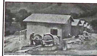
Construção de casas populares
