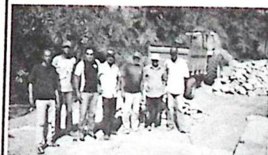
Calçamento da Avenida Santos Dumont
