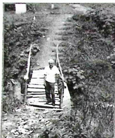
Ponte que liga a Avenida João Tomaz de Liz à estrada da "Linha"
