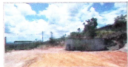
Trabalho de terraplanagem no alto do Bairro Regina Coeli onde em breve será construída a estação de tratamento de água.
