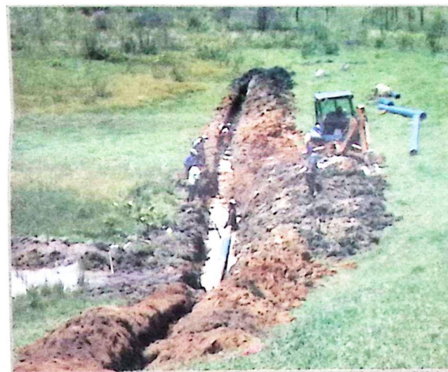
funcionários realizando a implantação do novo encanamento que trará água para a ETA.
