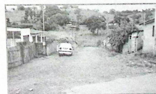
Parte da Rua Topázio onde falta o referido calçamento
