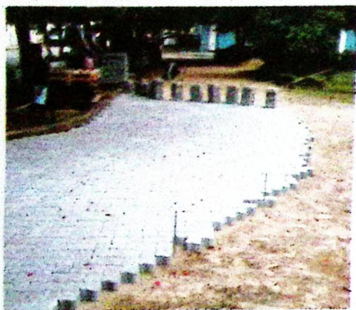
Início do calçamento da Praça da Rodoviária
